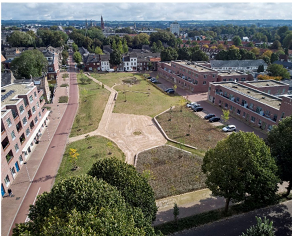
Figuur 5: In het project Blauwe Loper werden verouderde grondgebonden woningen gesloopt en vervangen door compacte drempelloze appartementen. Hierdoor werd de buurt levensloopbestendiger, kwam doorstromen op gang en ontstond er ruimte voor een buurtpark met wadi en een nieuwe wandel en fietsroute die de buurt met het centrum verbindt.
